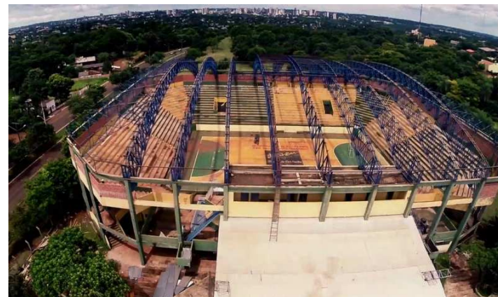
Recuperación del polideportivo de Pdte. Franco
