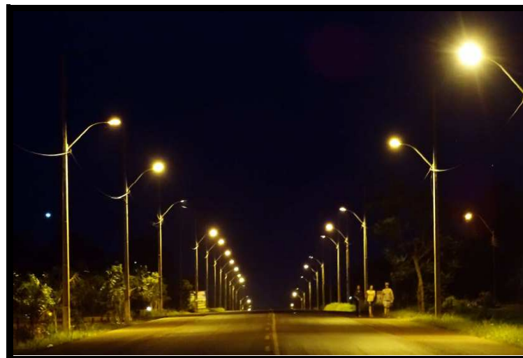
Construcción de pavimento tipo empedrado e iluminación en diferentes ciudades del país.
